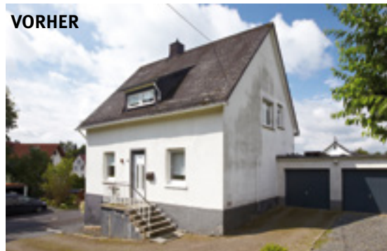
Zustand vor der Sanierung mit BauderPIR
