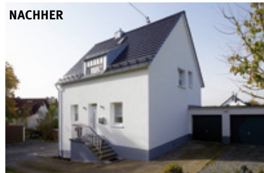
Trotz Aufsparrendämmung (BauderPIR 160 mm): Die Aufbauhöhe des Daches bleibt nahezu gleich
